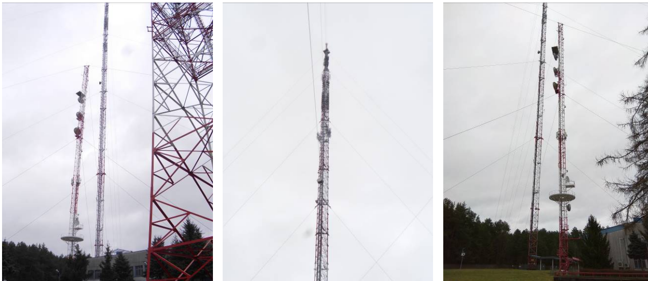
Widok obiektu wraz z zainstalowanym zespołem antenowym
